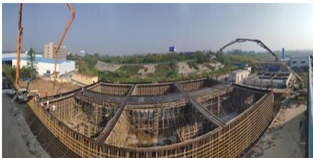
日处理污水4000吨的污水二期技改正在进行池体浇筑。
